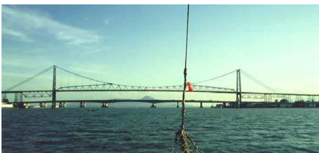
Zu den Weiterentwicklungen von Thangtong Gyalpos Kettenbrücken gehört die Kettenbrücke in Florianopolis/Brasilien mit einer Spannweite von 340 m.
