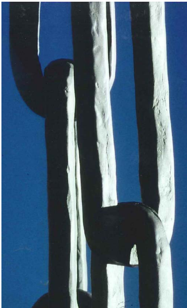
Die Ketten der Brücke von Chung Riwoche, auch nach vielen Jahrhunderten noch rostfrei
